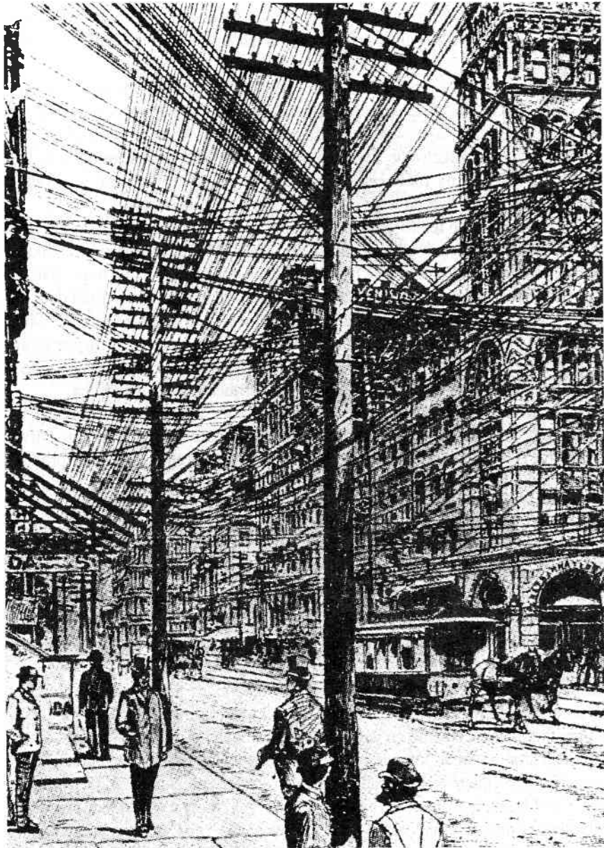
Figuur 7: Rond de eeuwwisseling werden telefoon- en telegraafdraden in de open lucht opgehangen aan palen
